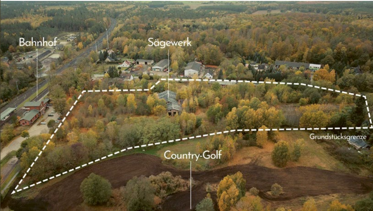
Aus Altem wird Neues: In Wiesenburg/Brandenburg entsteht das Ko-Dorf nahe dem Bahnhof mit Anschluss nach Berlin. Foto © agmm Architekten + Stadtplaner
